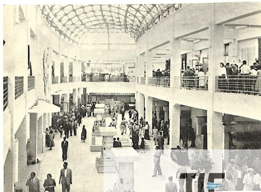
Vue intérieure du Pavillon de la Production Nationale d'Agriculture
