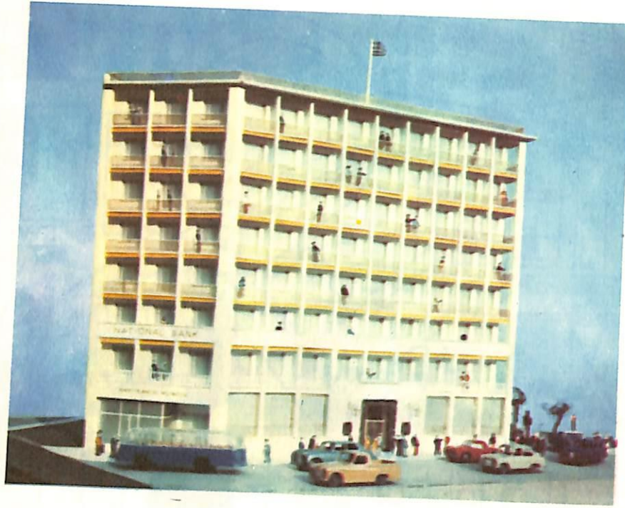
ΤΟ ΝΑΥΤΙΛΙΑΚΟΝ ΜΕΓΑΡΟΝ ΤΗΣ ΕΘΝΙΚΗΣ ΤΡΑΠΕΖΗΣ ΕΙΣ ΤΟΝ ΠΕΙΡΑΙΑ L'IMMEUBLE MARITIME DE LA BANQUE NATIONALE DE GRÈCE, AU PIRÉE
